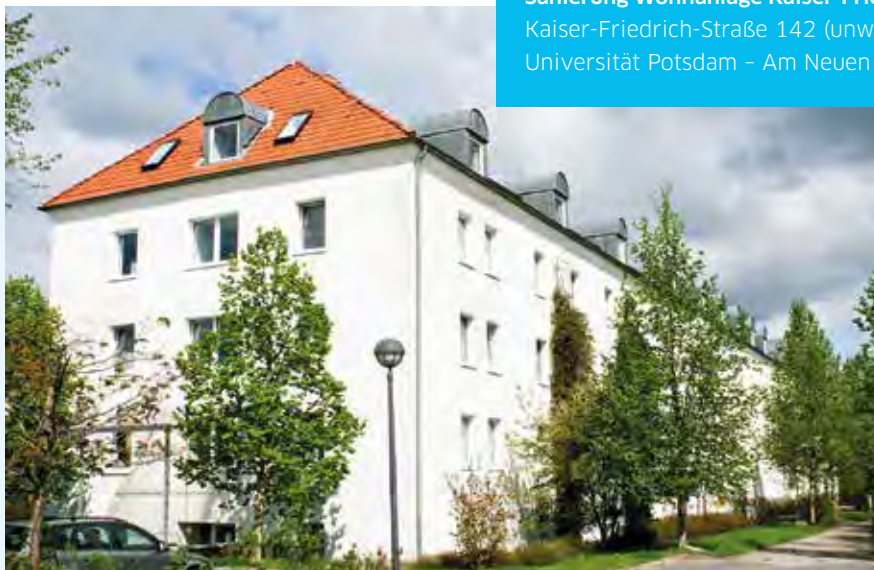
Sanierung Wohnanlage Kaiser-Friedrich-Straße 142
